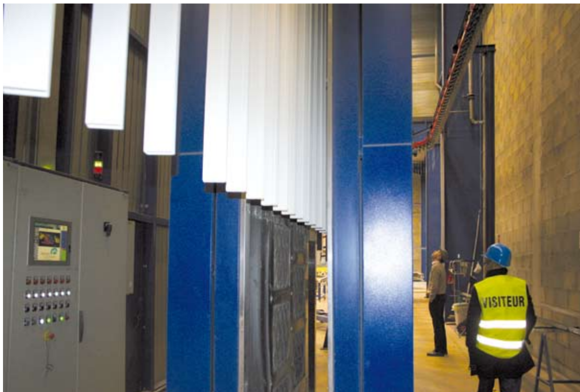
19 - Un'altra immagine dell'uscita dei pezzi dall'impianto di verniciatura.
